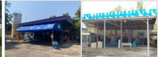
ภาพถ่ายก่อน-หลัง การปรับปรุงศูนย์ดูแลกลางวันผู้สูงอายุ ตำบลบ้านค้อ
