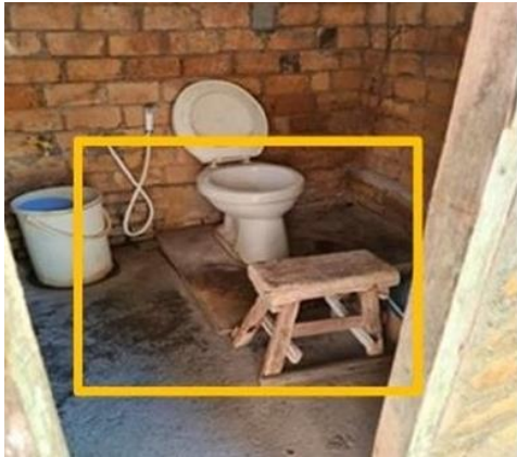
ภาพที่ 34 ลักษณะพื้นผิวและการใช้งานภายในห้องน้ำ ควรมีอุปกรณ์ช่วยพยุงตัวและพรมกันลื่น
