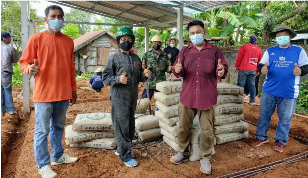
ภาพที่ 8 การก่อสร้างบ้านเพื่อคนพิการและผู้สูงอายุ (บรรจง, 2564)
