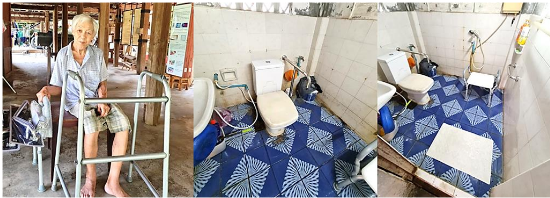
ภาพที่ 37 การปรับปรุงห้องน้ำเพื่อผู้สูงอายุ นายนิคม จันทรพรหม บ้านต้นแห่น้อย อ.สันป่าตอง จ.เชียงใหม่
