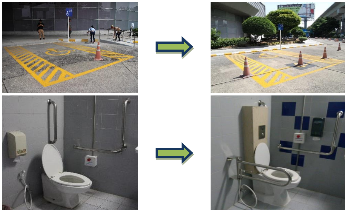
ภาพที่ 104 การปรับปรุงของอาคารสำนักงานหลักสี่ บริษัท การบินไทย จำกัด (มหาชน) (โครงการตรวจติดตามฯ)
