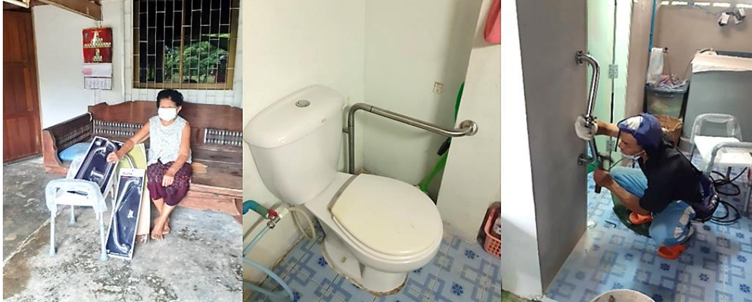
ภาพที่ 36 การปรับปรุงห้องน้ำเพื่อผู้สูงอายุ นางแสงคำ วงบุญเรือง บ้านต้นแห่น้อย อ.สันป่าตอง จ.เชียงใหม่
